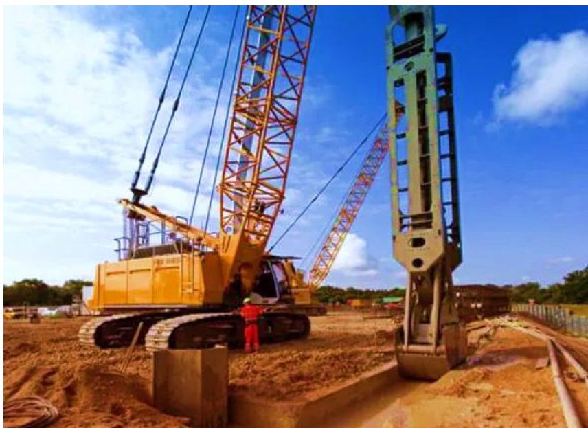
Rys. 2.4. Przykład głębienia wykopu z wykorzystaniem koparki linowej. W dolnej części widoczne jest zamontowanie elementu rozdzielczego dane sekcje [81].
