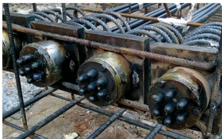
Rys. 1.15. Zainstalowane kotwienie bierne w sprężonej ścianie szczelinowej. Wykonanie Keller Polska [70].
