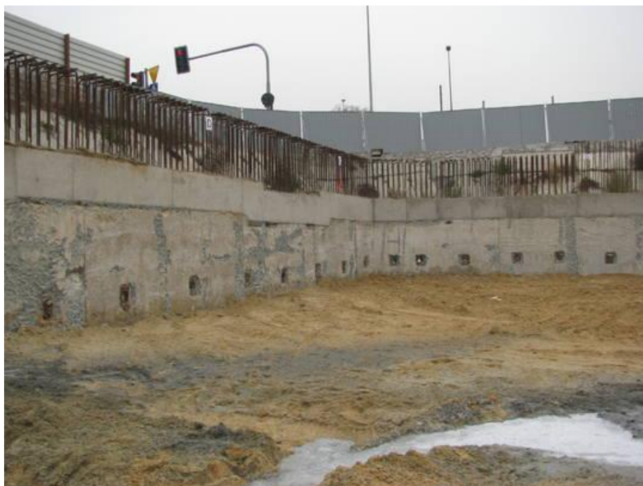
Rys. 2.6. Głębianie wykopu do poziomu pierwszego rozparcia [82].
