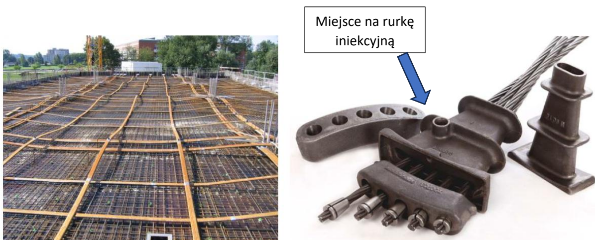
Rys. 3.16. System płaskich kabli sprężających z przyczepnością [90].
