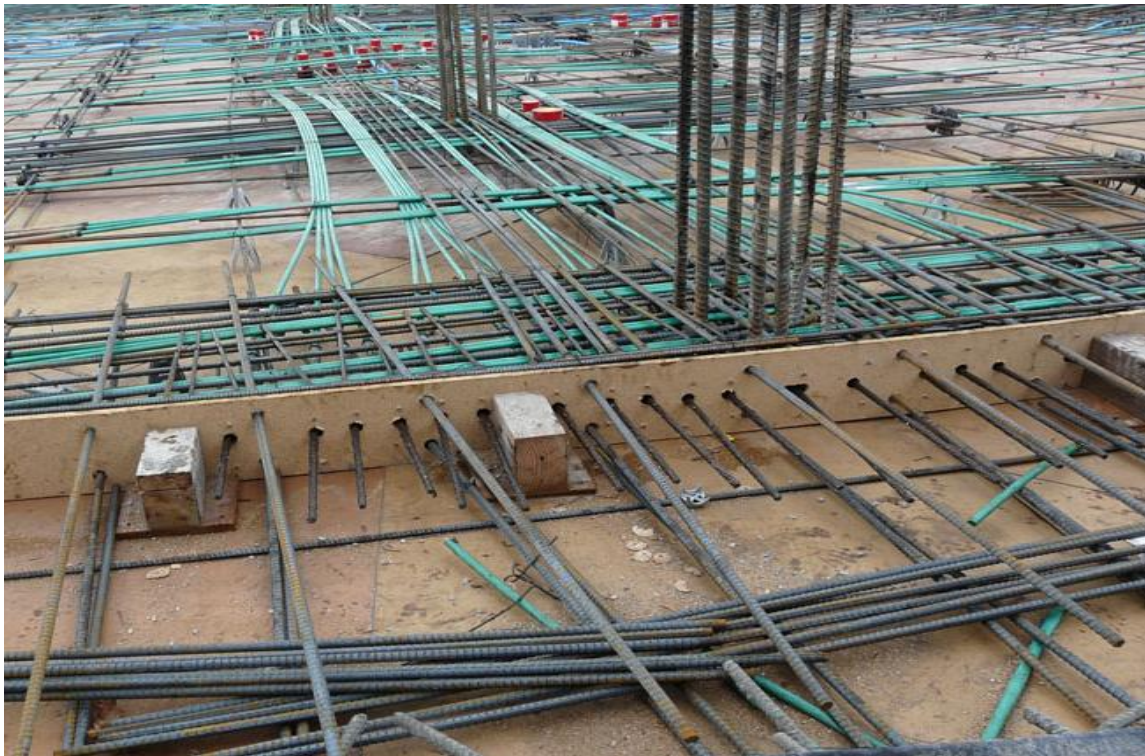
Rys. 3.13. Przykład ułożenia kabli sprężeniowych bez przyczepności w deskowaniu [90].
