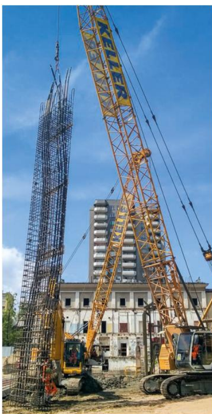
Rys. 1.16. Na zdjęciu widoczna jest faza poświęcono podnoszeniu i instalowaniu kosza zbrojeniowego z zainstalowanymi cięgnami sprężającymi w szczelinie wypełnionej bentonitem [70].
