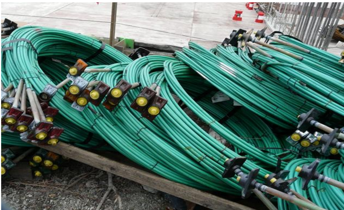
Rys. 3.11. Przywiezione na plac budowy kable sprężeniowe bez przyczepności czekające na wbudowanie [90].
