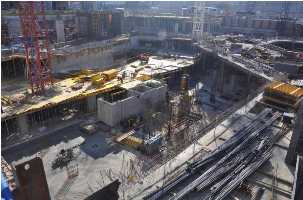
Rys. 2.9. Proces wykonywania elementów pionowych po wykonaniu płyty fundamentowej. Jednocześnie wykonuje się tradycyjne deskowanie poziome i betonuje się otwór technologiczny [85].
