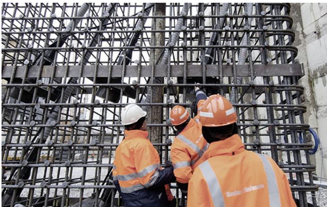
Rys. 1.19. Ciężna sprężające w klatkach wzmacniających stabilizują całą konstrukcję [71].
