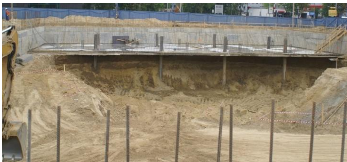
Rys. 2.8. Proces usuwania urobku spod wykonanego stropu rozporowego. Widoczne są słupy tymczasowe podtrzymujące stropy rozporowe [84].
