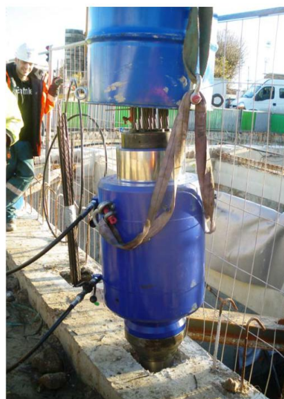
Rys. 1.11. Realizacja sprężonej ściany szczelinowej przez konsorcjum Soletanche – Freyssinet [69].
